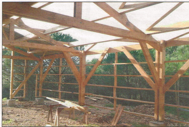
Construction d'une bergerie avec ossature bois et charpente
